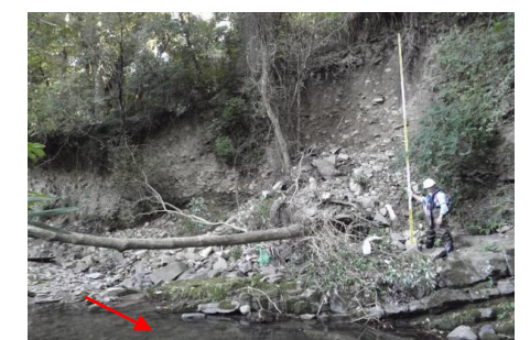
自然護岸の土砂流出
