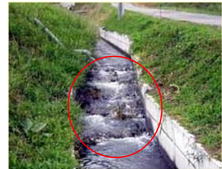
ふとんかごによる簡易魚道 引用・加筆：農林水産省関東農政局資料
