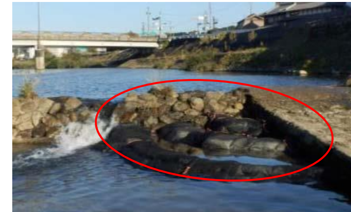
土のうによる簡易魚道 引用・加筆：国土交通省木津川上流河川事務所資料
