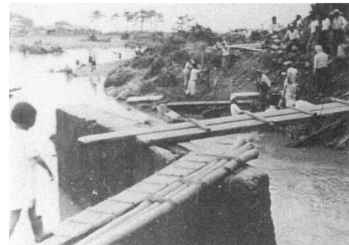
昭和27年7月10～11日（前線性豪雨） 岬町多奈川・谷川付近 東川右岸荒廃状況 落合橋より望む
