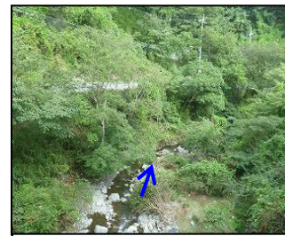
③ 上流端付近
