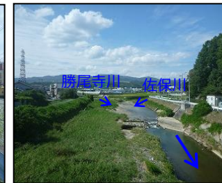
③ 幣久良橋より上流
