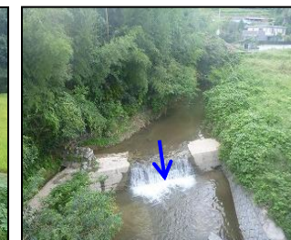
⑥ 上流端付近
