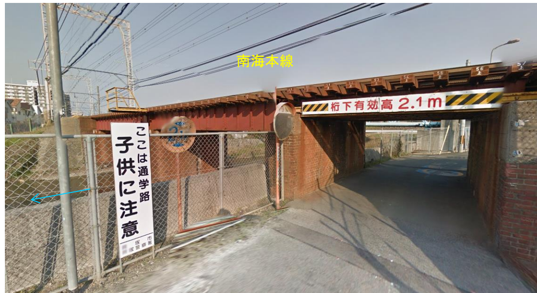
写真-3 南海本線橋梁下道路
