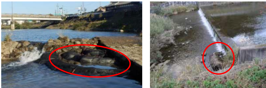
図-2.5 土のうやふとんかごによる簡易的な魚道のイメージ図
