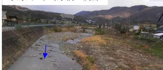
余野川 中河原橋上流部
