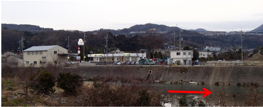
越水地点付近(兵庫県側から撮影)
