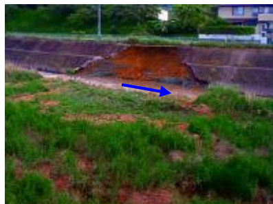
平成23年5月30日 樫井川 下村橋上流左岸
