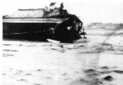
写真 昭和27年7月11日(前線性豪雨) 阪南市尾崎町付近 男里川堤防決壊
