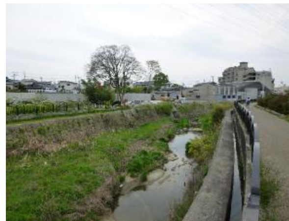
河道内の土砂堆積
