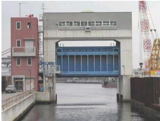
（事例）正蓮寺川水門
