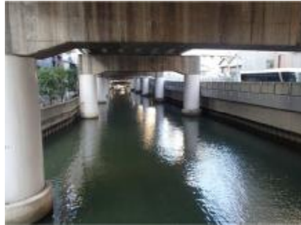
図-1.20 上大和橋下流
