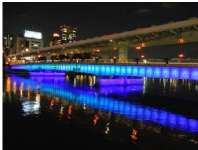
図-1.30 天満橋（橋梁のライトアップ）
