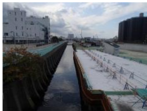
図-1.24 北港新橋下流
