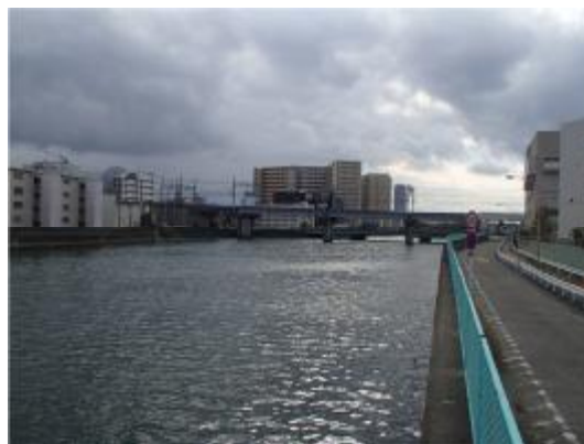
図-1.26 北港通下流
