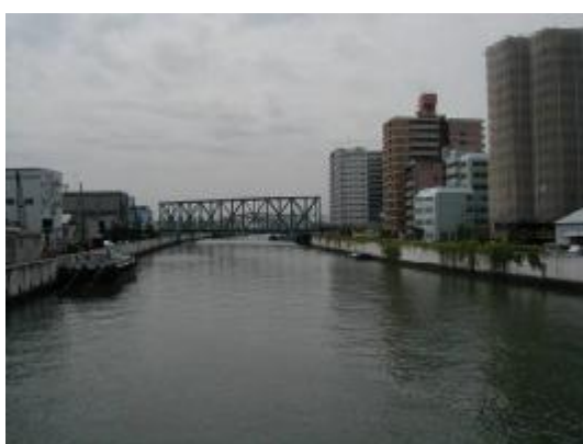
図-1.12 木津川（尻無川分派点上流）
