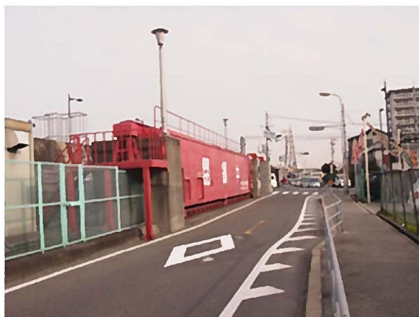
神崎大橋左岸 防潮鉄扉
