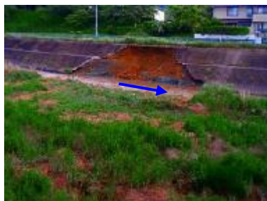
平成23年5月30日 榎井川 下村橋上流左岸
