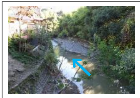
写真② 中流部 (谷川橋下流付近)
