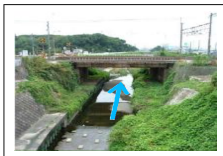
写真③ 下流部 (檜尾川橋下流付近)
