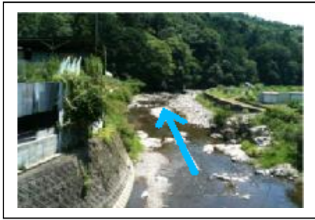
写真① 上流部 (摂津橋大橋下流付近)
