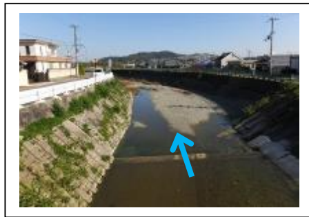
写真④ 下流部 (水無瀬橋下流付近)
