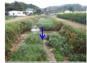
⑤ 大原川橋より上流
