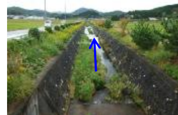
④ 樋詰橋より下流
