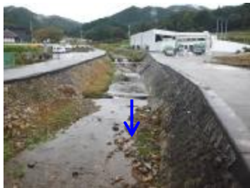
① 野間川橋より上流
