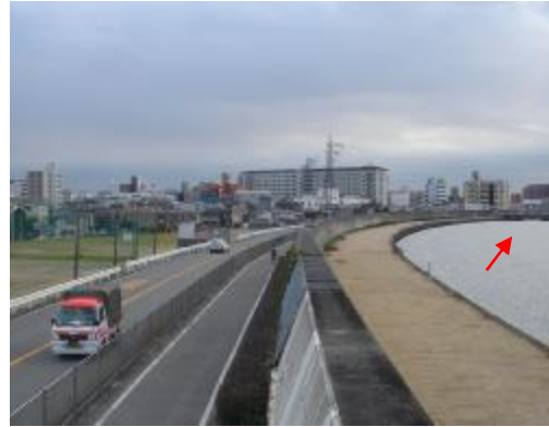
写真 1.4 防潮堤状況 (神崎川：左門殿川分派後)
