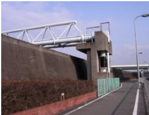
写真 1.5 防潮堤状況 (神崎川：出来島大橋下流)
