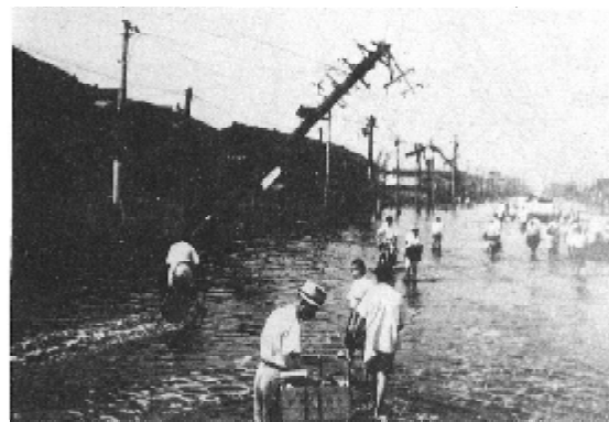
写真 1.1 浸水状況 (国道2号)
