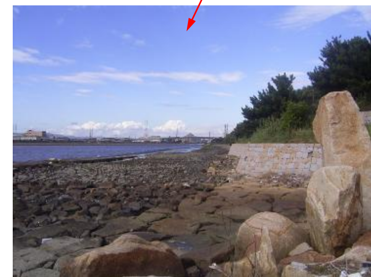
図 1.16 矢倉緑地（神崎川上流を望む）
