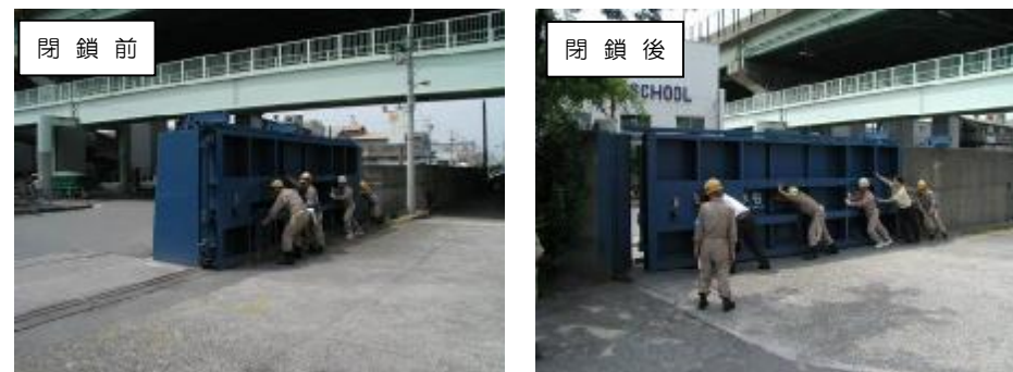
図 1.77 防潮鉄壁（水防訓練の様子）
