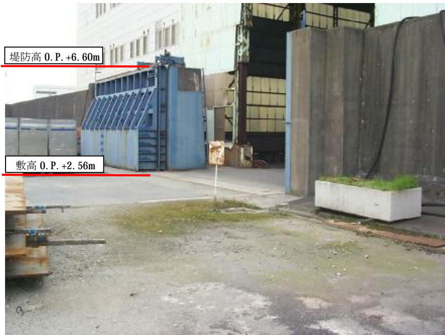
図 1.85 木津川左岸2号鉄扉
