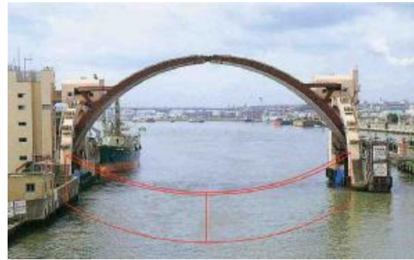
図 1.75 安治川水門（赤色は水門閉鎖時を示す）
