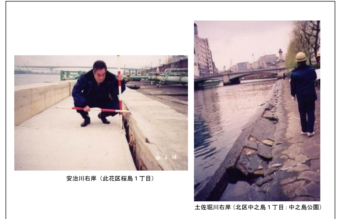
兵庫県南部地震による対象河川の防潮堤損傷状況
