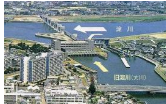
図 1.76 毛馬排水機場
