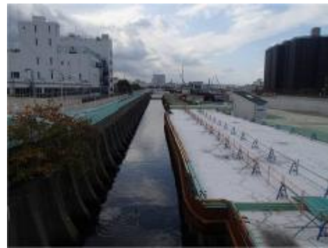
図-1.24 北港新橋下流
