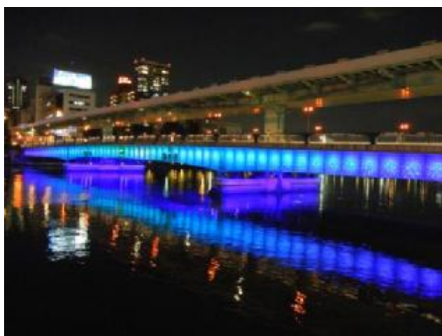
図-1.29 天満橋（橋梁のライトアップ）
