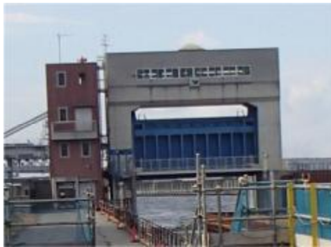
図-1.23 しょうれんじがわ 正蓮寺川水門
