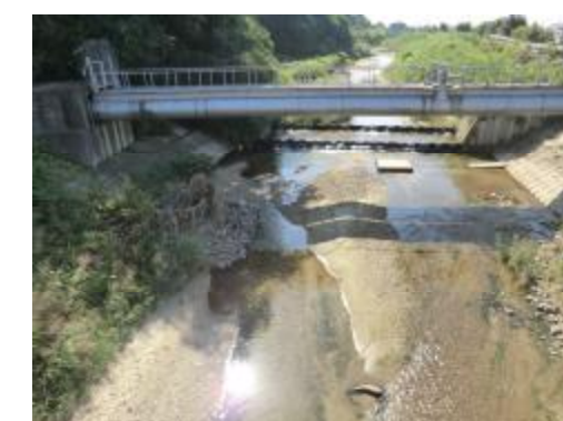
穂谷川土砂堆積状況
