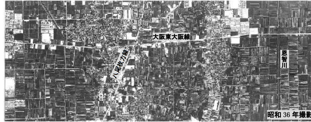
第二寝屋川上流部(恩智川合流点周辺)
