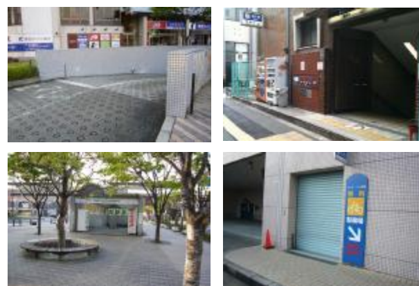
写真 1.6 地下施設(入り口)
