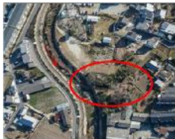
② 旧川1区間 現況写真
