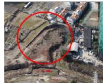
③ 旧川2区間 現況写真
