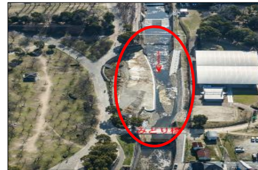
① 中央公園区間 現況写真
