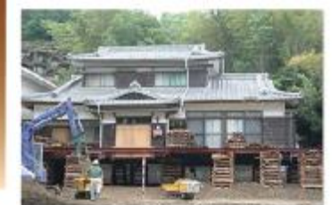
宅地嵩上げ・ピロティ
