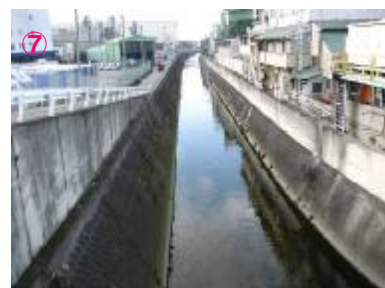
⑦ 落堀川（大正橋より下流） コンクリートブロック護岸の河川で人工的な様相です。
