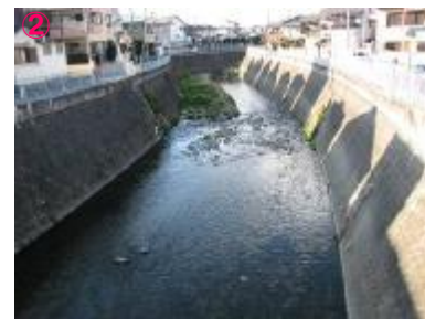
② 東除川（一津屋橋より下流） コンクリートブロック護岸の河川で人工的な様相です。堰が多く、部分的に砂州等が形成されています。
