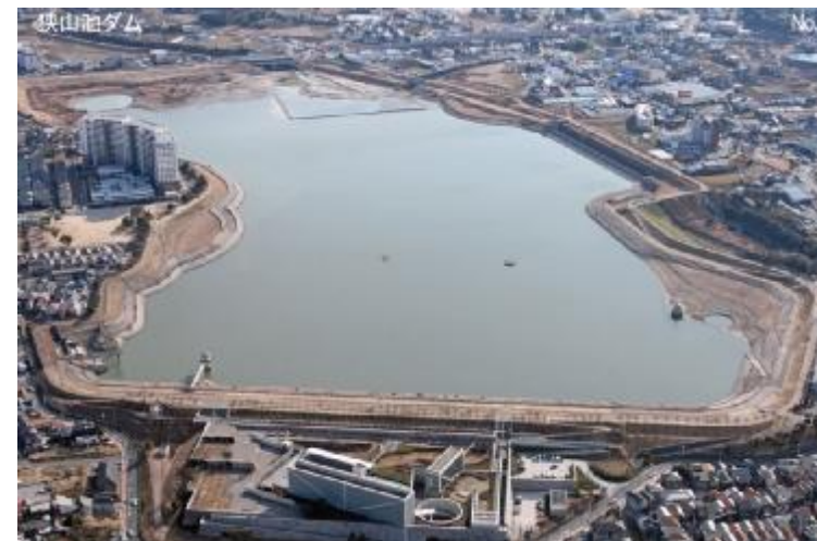
現在の狭山池ダム (平成21年)
