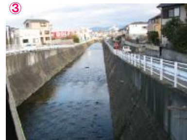
③ 東除川（新伊勢橋より上流） コンクリートブロック護岸の河川で人工的な様相の直線河道です。部分的に砂州等が形成されています。
