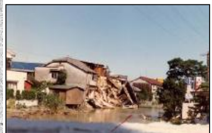
⑤西除川(新西除橋より上流)S57.8
