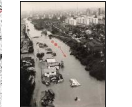
③狭間川合流点より上流S57.8
