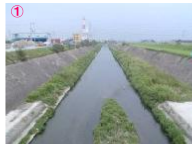
① 東除川（明治小橋より下流） コンクリートブロック護岸の河川で人工的な様相ですが、右岸側は並流する大和川により緑と水面の広がりを見せています。
