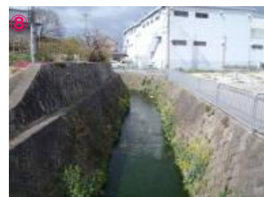
⑧ 平尾小川（無名橋より下流） コンクリート三面張りの河川で人工的な様相です。
