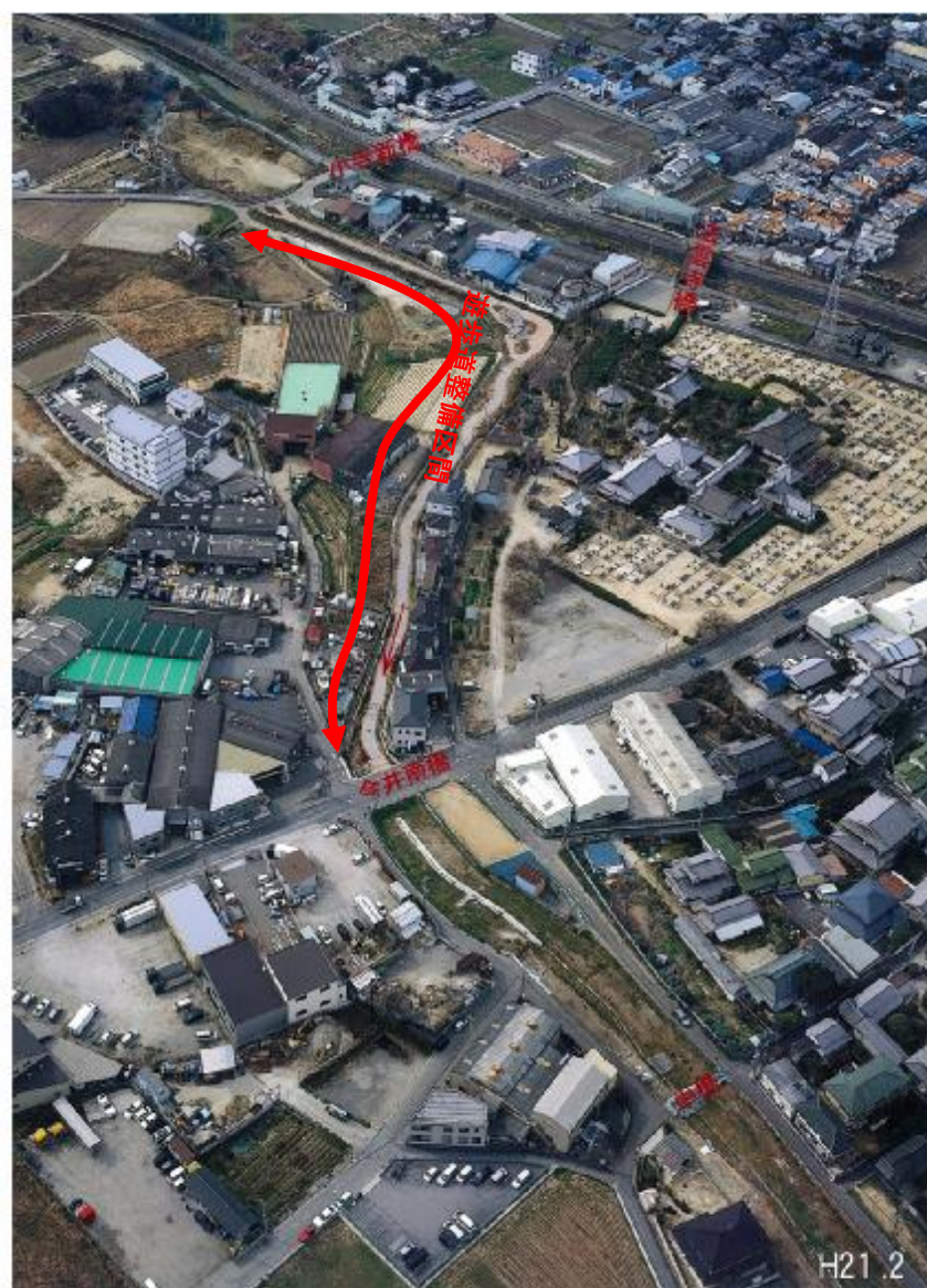
西除川旧河川敷遊歩道整備
