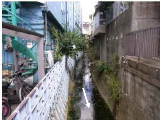
【現況の河道状況】
