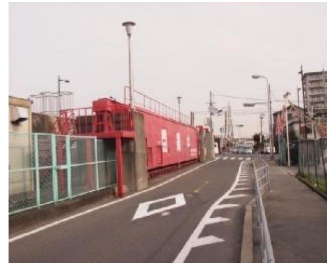
神崎大橋左岸防潮扉(国道2号鉄扉)
