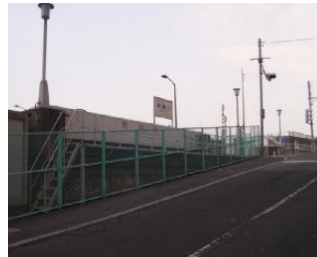
千北橋左岸防潮扉(アルミ防潮扉)
