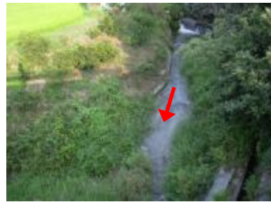
写真④ 水越川（楠木橋付近）
