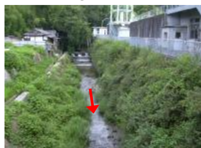
写真④ 石見川（上之宮橋付近）
