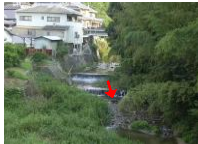
写真③ 千早川（千早大橋付近）
