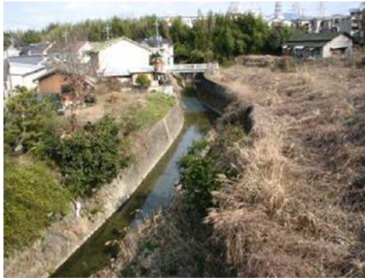
西除川(狭山池ダム上流)
