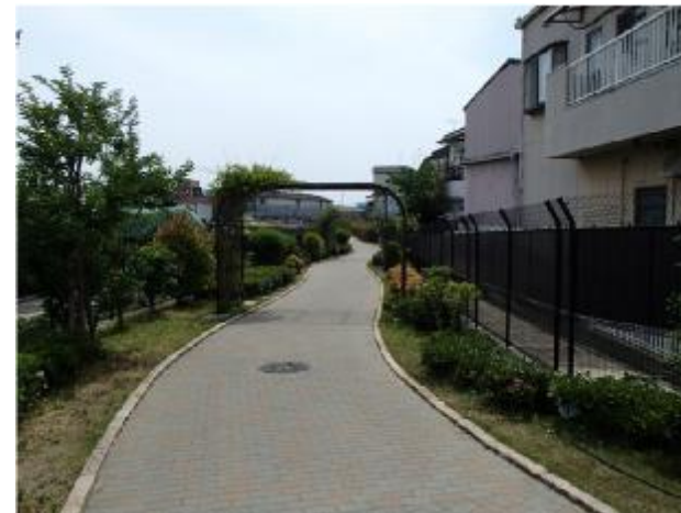
遊歩道整備状況
