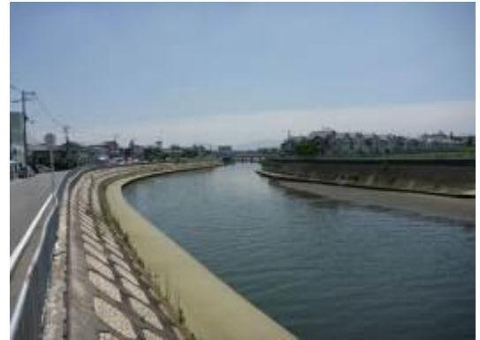
図 1.3 石津川下流部
