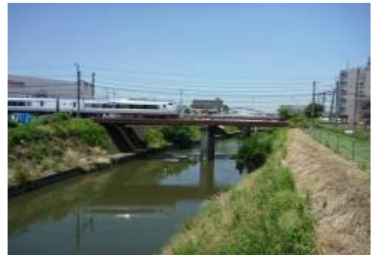
図 1.4 石津川中流部
