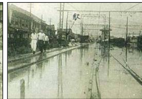
南海泉大津駅構内(泉大津市)
