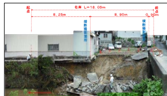
松尾川(冬堂橋下流右岸)
