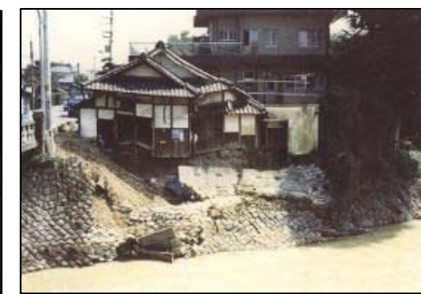
槇尾川川中橋下流(和泉市三林町)
