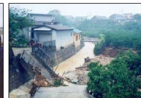
槇尾川地蔵橋付近(和泉市坪井町)
