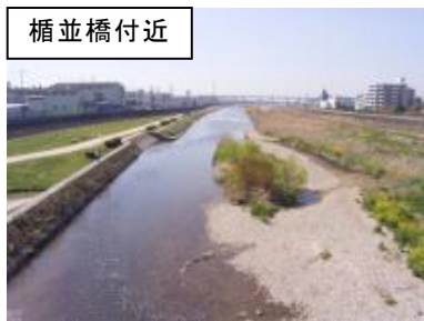
図 1.2 下流部（大津川）
