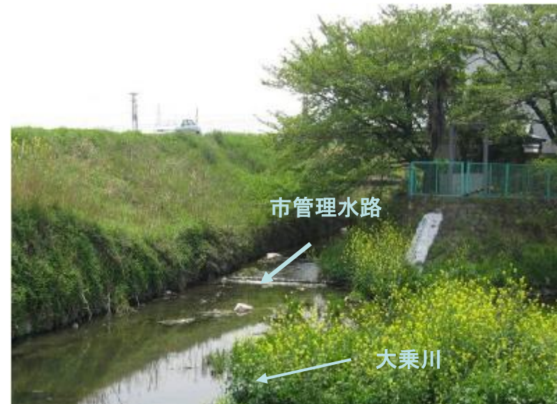
市管理水路 大乘川合流点の状況
