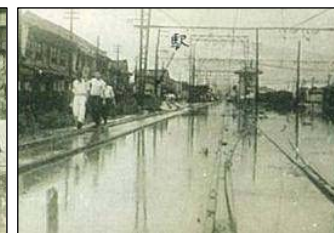
南海泉大津駅構内(泉大津市)
