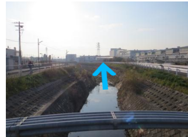
③女瀬川橋より下流を見る
