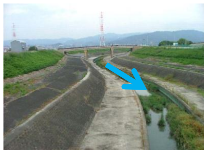
② 演習橋より上流を見る。
