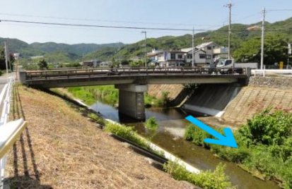
③ 水無瀬橋下流より水無瀬橋を見る
