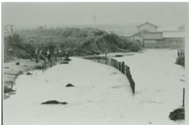
昭和28年9月26日被災写真①(檜尾川)
