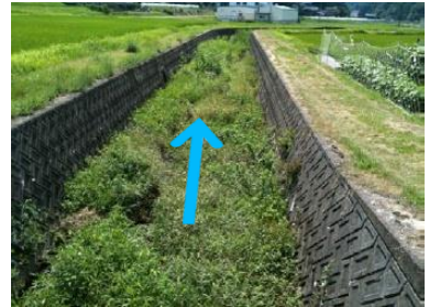
④中畑口付近より下流を見る
