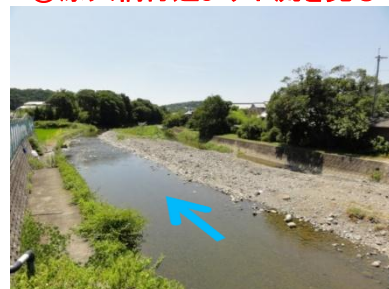
④原大橋付近より下流を見る
