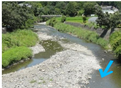
②大森橋～千原橋(上流を見る)
