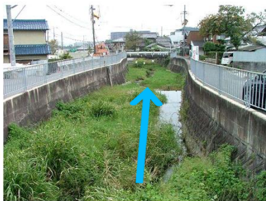
②無名橋から下流を見る
