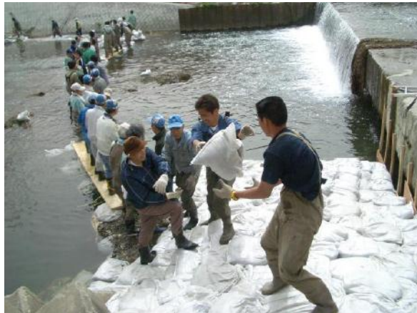
仮設魚みちの整備状況
