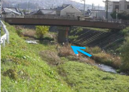
④ 水無瀬橋上流より下流を見る
