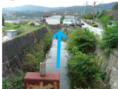
②無名橋から下流を見る
