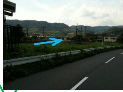
⑥ 調子橋上流より調子橋を見る
