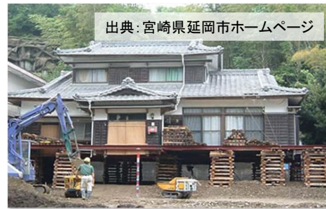
宅地嵩上げの施工事例
