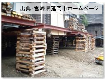
宅地嵩上げの施工事例
