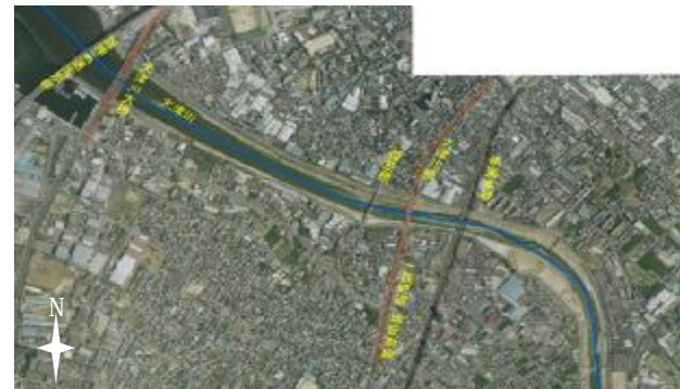
大津川下流部の状況
