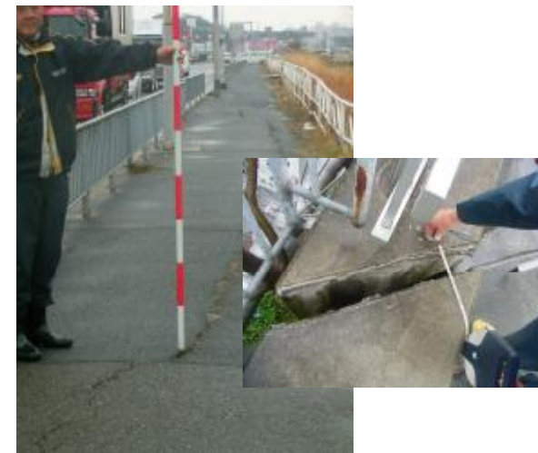
図 2.2.3 河川巡視の状況
