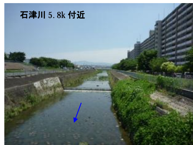
図 1.2.12(2) 万崎橋上流の状況（石津川）
