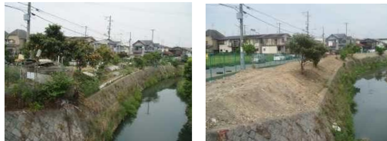
図 1.2.7 不法占用の自主撤去前と自主撤去後
