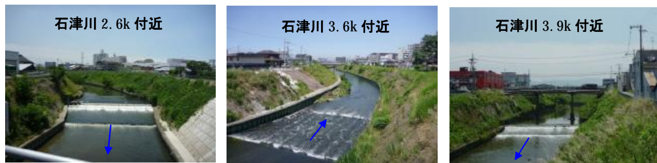
図 1.2.13 石津川の堰や落差工
