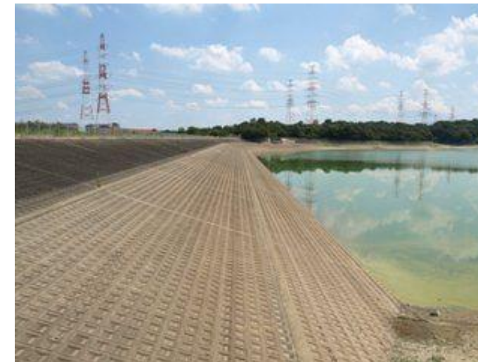
図 1.1.8(4) 本堤防（池の北側）
