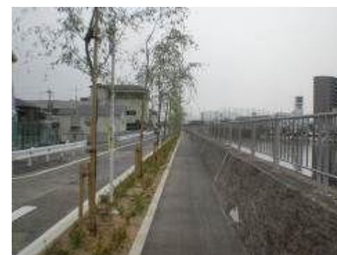
図 1.2.15 石津川を基軸とした緑化の取組み（石津川河口部）
