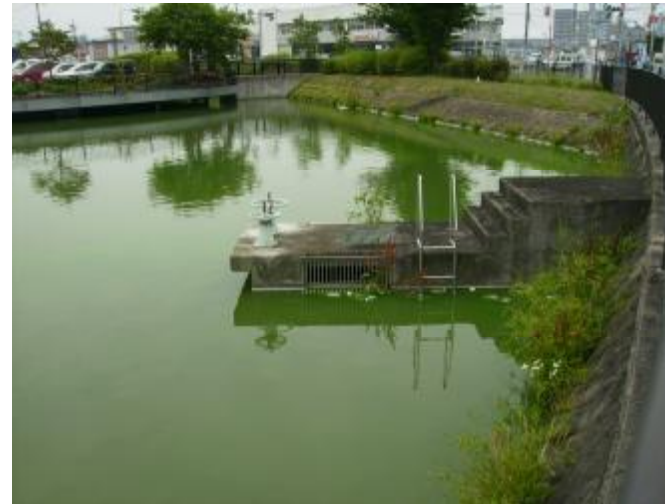
図 1.1.5(3) 石津川流域のため池（家原大池）
