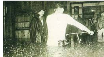
1. 泉大津市役所玄関（泉大津市）
