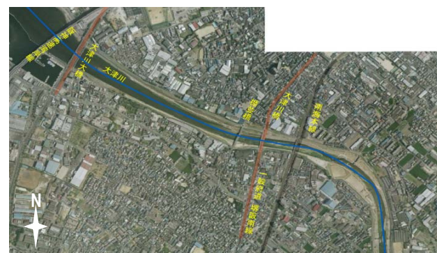
大津川下流部の状況
