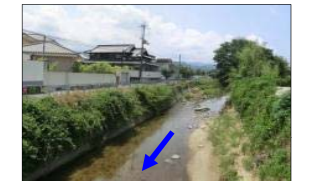
4. 神田橋付近（横尾川上流部）
