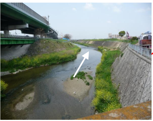
80mm程度対応済みの放水路 (落堀川合流点付近)
