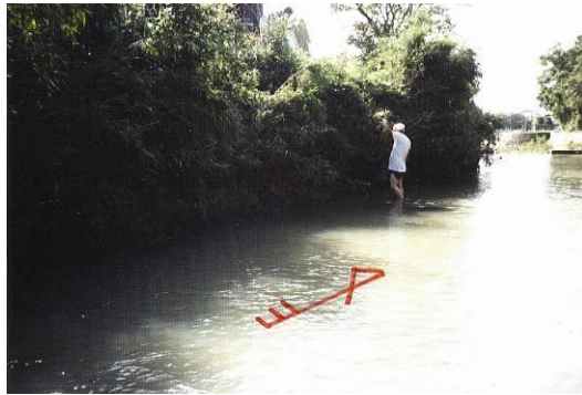
③平成7年豪雨被災写真 (南海橋上流)
