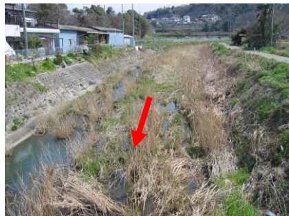
完成区間(宮下橋上流)
