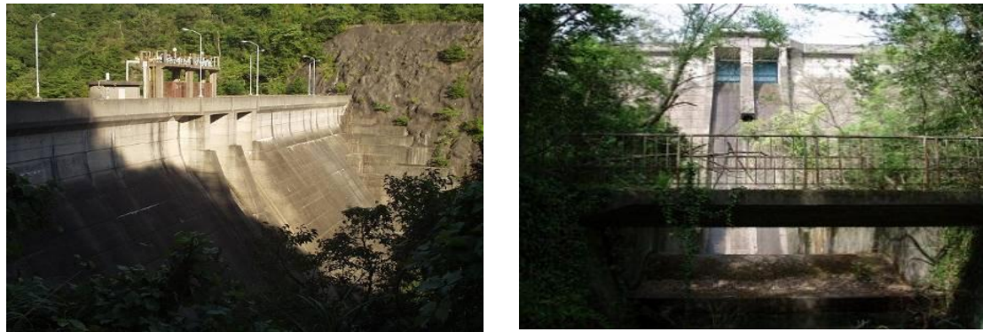
図1.58 逢帰ダムの堤体の状況
