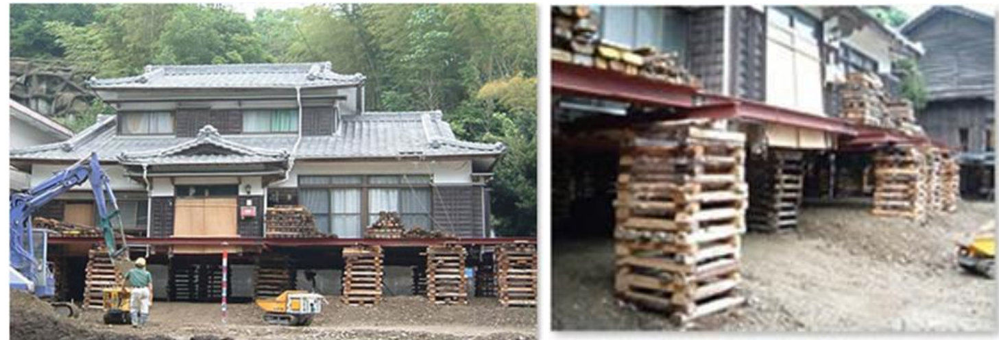
○土地利用一体型水防災事業（宅地嵩上げ）の施工事例
