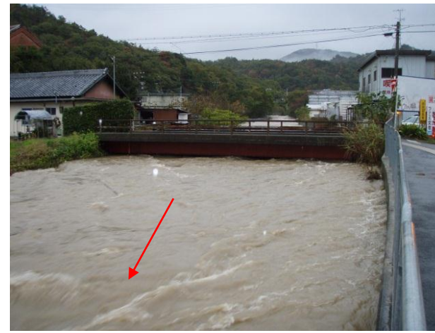
①平成21年11月豪雨写真 （南海橋下流付近）
