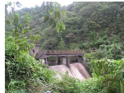
新池（榎合川）の放流施設（グラフ上）
