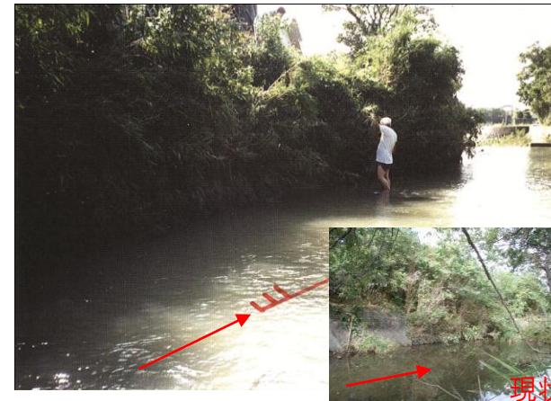
③平成7年豪雨被災写真（南海橋上流）
