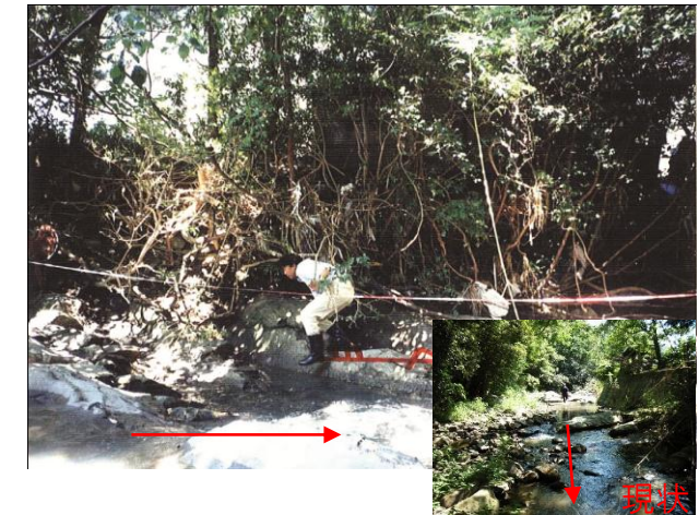
④平成7年豪雨被災写真（中山橋上流）
