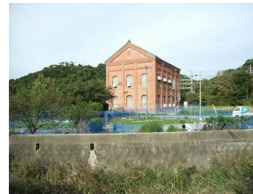
③南海電鉄深日変電所
