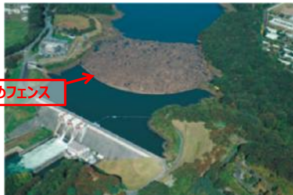
図1.7 流木止めフェンス(貯留型ダム)
