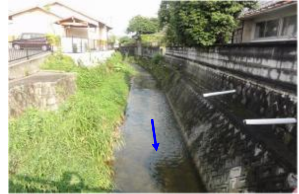
住吉川の上流区間の状況 （万福橋上流付近）
