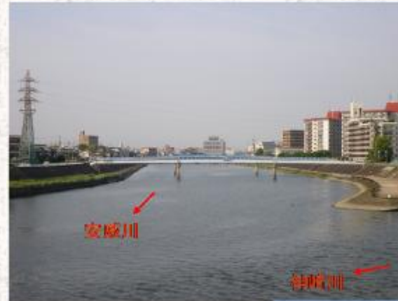
＜安威川下流部＞
