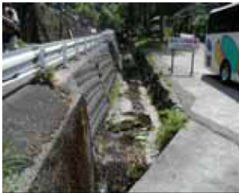
現状の三面張り（和泉市楨尾山町）
