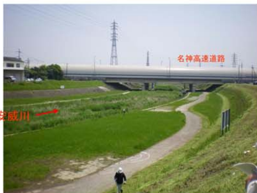
①安威川名神高速道路上流
