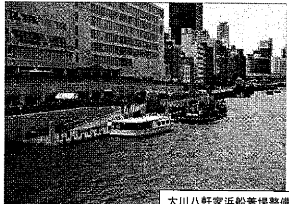
大川八軒家浜船着場整備
