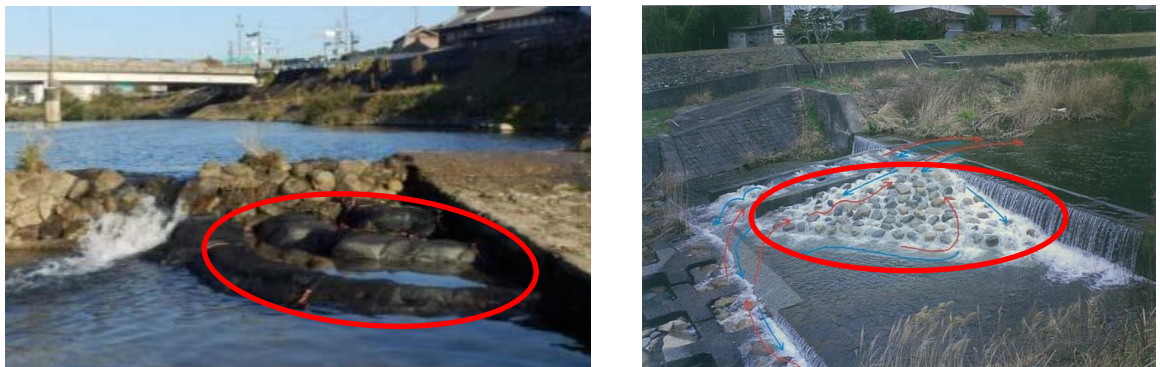
図-2.5 土のうや水辺の小わざによる簡易的な魚道の事例
