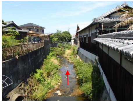
⑦紺屋上橋下流
