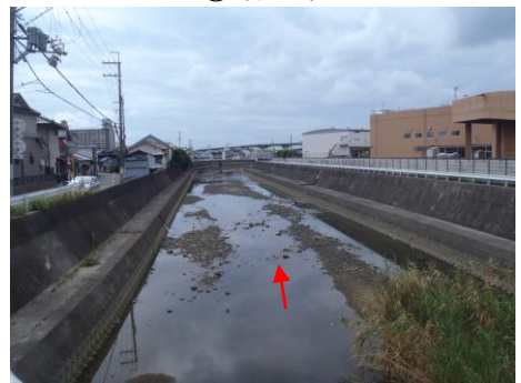
②高潮区間の防潮堤防(住吉橋下流)
