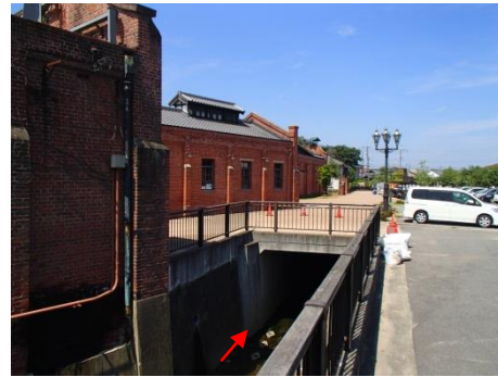
⑧煉瓦館付近
