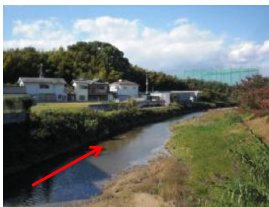
【金熊寺川・(幡代橋下流)】
