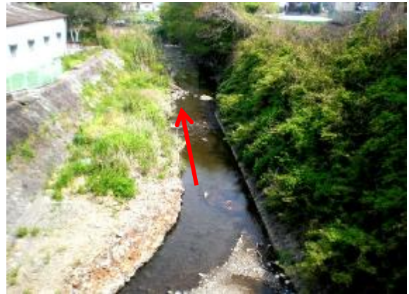
【菟砥川 (下亀橋下流)】
