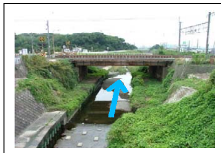
写真③ 下流部 (檜尾川橋下流付近)
