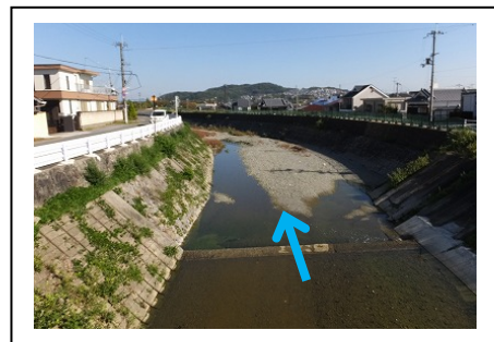
写真④ 下流部 (水無瀬橋下流付近)
