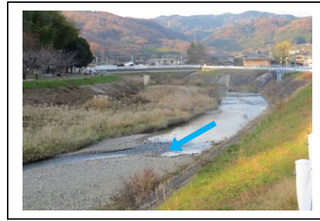
写真② 中流部（正恩寺橋下流付近）
