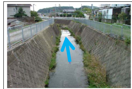
写真② 下流部(西山川流付近)
