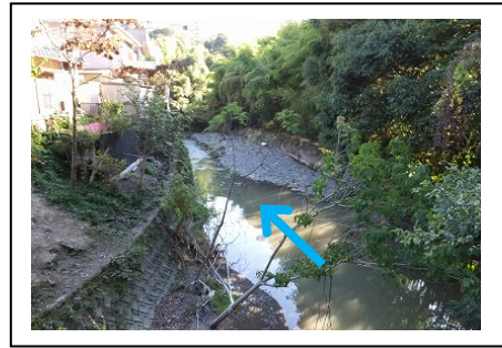
写真② 中流部 (谷川橋下流付近)
