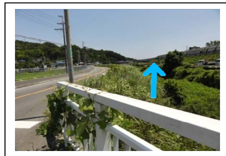
写真② 中流部 (磐手橋下流付近)
